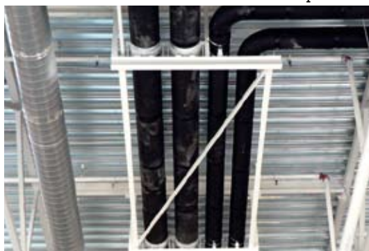
El equipo de Dmitry Ivanuk instaló 40.000 m de coquillas de Armaflex y 6.000 m 2 de material en planchas de Armaflex en el complejo comercial Mega Parnas.
