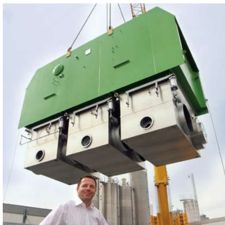
El sistema premontado se transportó hasta Münster como carga especial y después se erigió en su posición empleando una grúa especial de 500 t (en primer plano: Dr. Dirk Seiling, director de seguridad y de calidad de Armacell).
