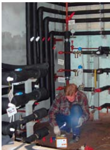
Fotografía del proyecto ganador: Aislamiento con Armaflex de una planta de refrigeración industrial, llevado a cabo por ZAO 'OK'
